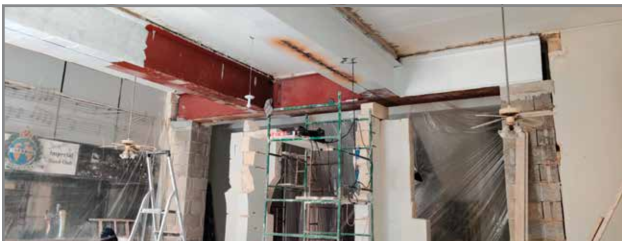
Is-sitt travi f'posthom fuq il-kolnna wara li sar ix-xogħol ta' welding u waqt li kienu qed jiġu miżbugħa.
